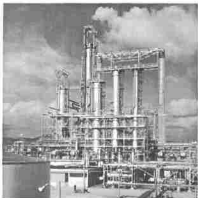
Raffinerie de pétrole. Rouen est un centre pétrolier très important.
