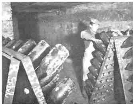
Dans une cave de Champagne. La fabrication du champagne exige de longs soins. Ici, l'ouvrier « tourne » les bouteilles.
