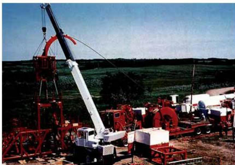
الشكل (4 - 23): وحدة حفر ملفوف الأنبوب.
