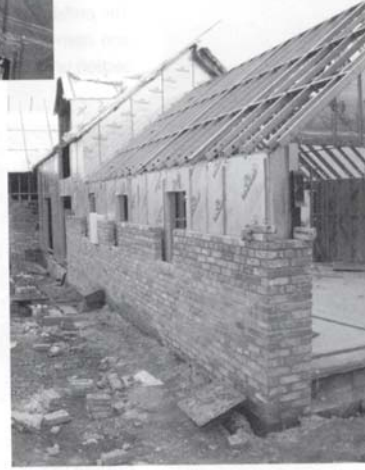
الشكل 48.7 استخدام مادة عزل/ تغليف صلبة
