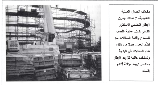
الشكل 21.7 استخدام السقالات في إقامة جدران الإطار
