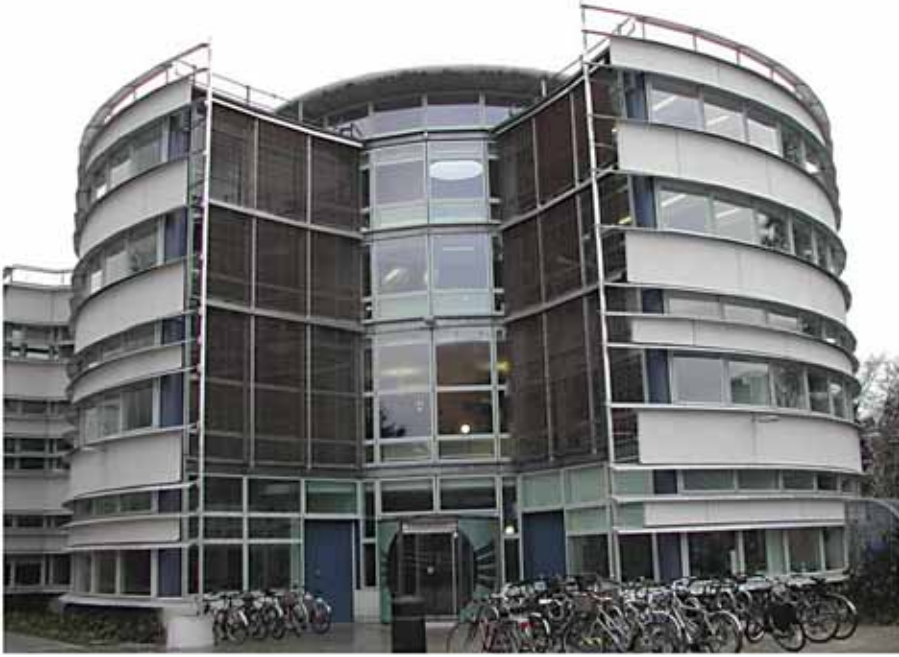
(الشكل 19.5) أجهزة تظليل من الألومنيوم - كلية اللاهوت، جامعة كامبردج. المعمارين: إدوارد كولن (Edward Cullinan). صورة: آرثر ليونز (Arthur Lyons).
