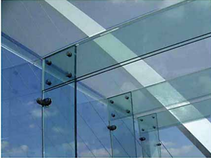
(الشكل 27.7) تفاصيل الزجاج البنيوي - سرادق عند جسر غيتسهيد الألفي؛ المعمارين ويلكنسون إير.
