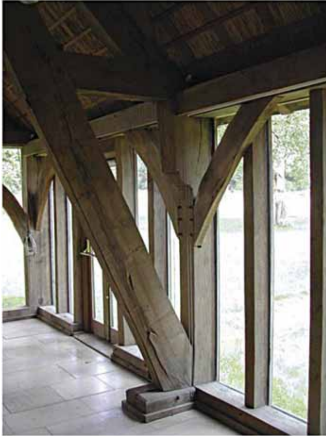
(الشكل 8.4) بناء بلوط تقليدي - قاعة البلوط الكبرى، مشتل وستونبيرت، غلوسسترشاير المهندسون المعماريون: رودريك جيمس. المصور: آرثر ليونز.
