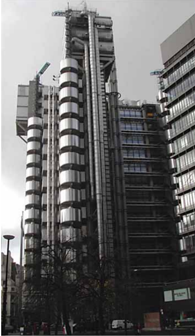
(الشكل 17.5) أعمال التشييد بالفولاذ المقاوم للصدأ مبنى لويدز في لندن. المعمارين: روجرز ستايرك هاربور (Rogers Stirk Harbour) وشركاه. صورة: آرثر ليونز (Arthur Lyons).
