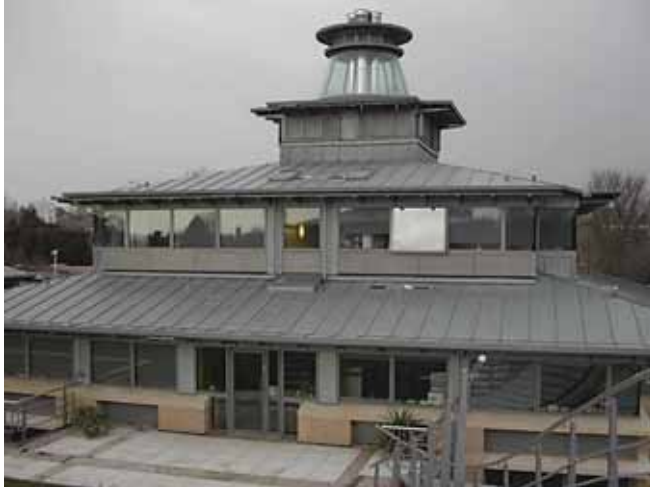
(الشكل 30.5) التسقيف بسبائك الزنك - مركز العلوم الرياضية بجامعة كامبردج. المهندسون المعماريون: إدوارد كولنن (Edward Cullinan). صورة: آرثر ليونز (Arthur Lyons).
