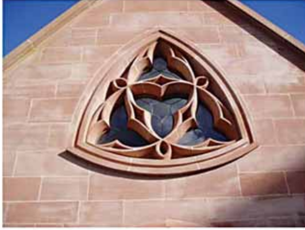
(الشكل 4.9) حجر لوكار الرملي الأحمر - مدرسة تشستر للغناء المعماريون: آرمل وسنيل. صورة الحجر الطبيعي مزودة من قبل أحجار ستانكليف.
