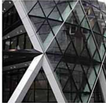
(الشكل 19.7) التزجيج وتفصيل له - المبنى السويسري، لندن.
