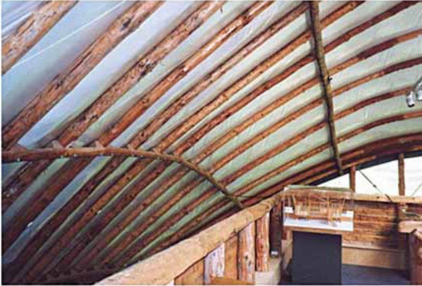
(الشكل 19.4) بناء من أعمدة الخشب - منتزه هوك، دورست - لودج (Edward Cullinan Architects and Buro Happold)، والعمل الداخلي (Frei Otto, Ahrends Burton and Koralek and Buro Happold). المصوّرون: (Courtesy of Allan Glennie).
