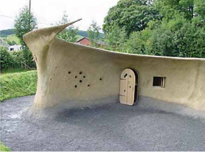
(الشكل 4.17) بناء من الطين والقش - منزل الحكايات، مركز (Bleddfa) للفنون، (Wales, Powys) المعماري، (Tono Mirai) الصورة: بإذن (Richard Weston).
