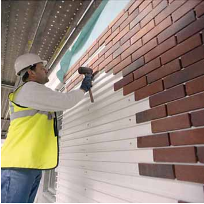
(الشكل 24.1) منظومات إكساء الآجر. الصورة بالإذن من (Courtesy of Corium, a division of Baggeridge Brick Plc.)
