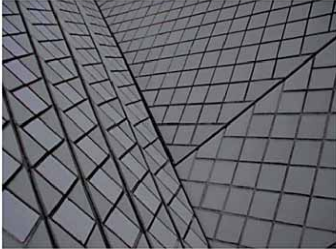
(الشكل 1.8) خزف سقف دار الأوبرا في سيدني وتفصيله، المعمارين: (Jern Utzon and Ove Arup). الصورة: (Arthur Lyons).
