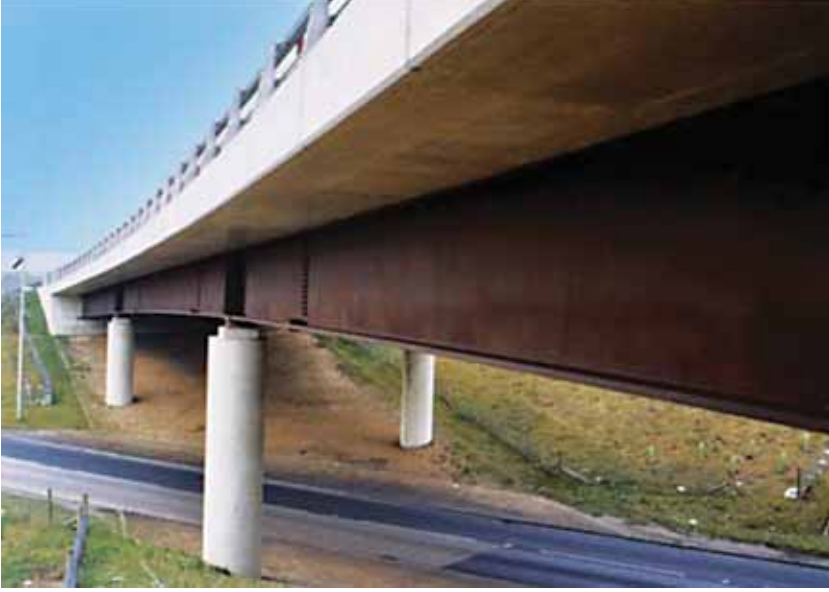
(الشكل 16.5) فولاذ كورتن (Corten) المقاوم للعوامل الجوية - تقاطع طرق شيفيلي (Chieveley). الصورة: بإذن من كورس (Corus).
