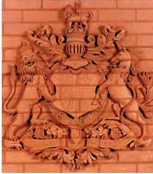
(الشكل 22.1) شغل الآجرّ تزييني منحوت. الصورة بإذن (Baggeridge Brick Plc).
