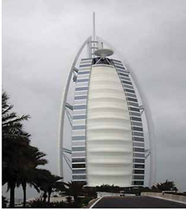
(الشكل 14.10) غشاء مشدود من الألياف الزجاجية المغلفة بالتفلون. فندق برج العرب في دبي المعماريون (WS Atkins) تصوير آرثر ليونز.
