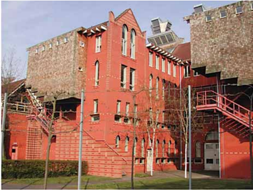
(الشكل 16.1) أشغال أجبرّ تزييني - مبنى الملكة، جامعة دو مونتفورت، لايستر. المعمار يون (Short Ford & Associates الصورة: آرثر ليونز (Arthur Lyons)).
