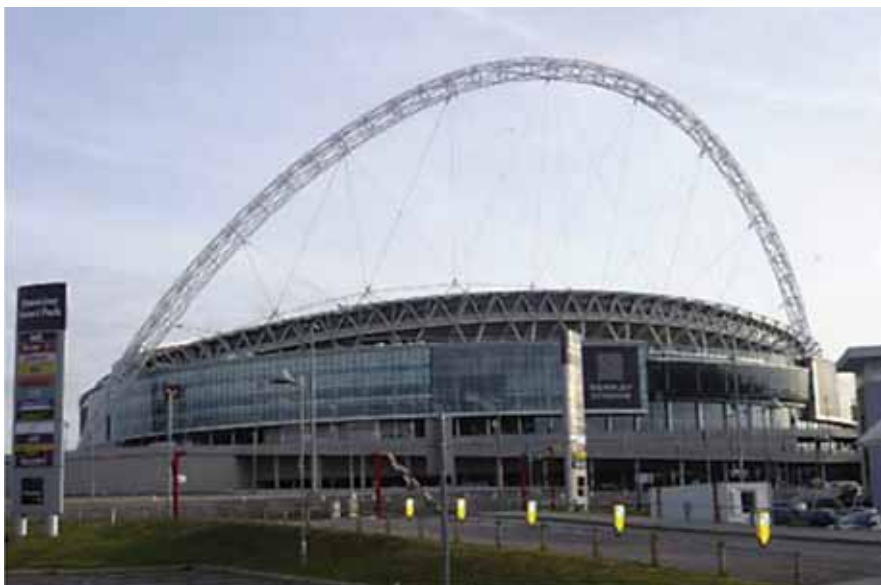
(الشكل 9.5) الأشغال الفولاذية البنيوية. ملعب ويمبلي (Wembley) في لندن. المهندسون المعماريون: فوستر (Foster) وشركاه. الصورة: آرثر ليونز (Arthur Lyons).
