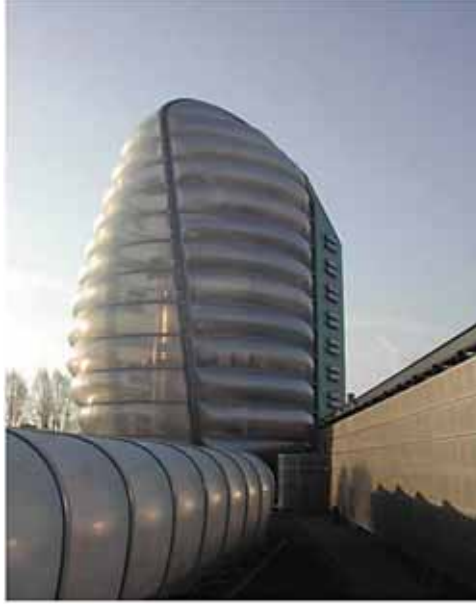
(الشكل 16.10) (ETFE) مركز الفضاء الوطني في لايستر المعماريون غريمشو تصوير آرثر ليونز .
