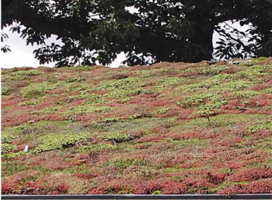
(الشكل 10.6) سطح أخضر مكثف - وستونبيرت أربيريتوم، غلوسسترشاير.
