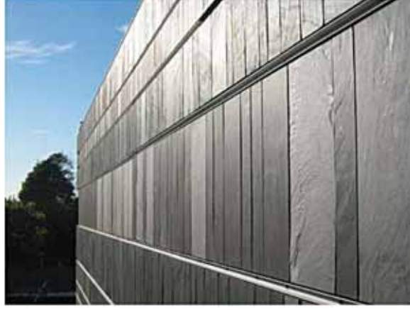
(الشكل 20.3) تغطية خارجية خرسانية مسبقة الصنع مغطاة بشرايح الأردواز، متحف سوانزي. الصورة بإذن (Trent Concrete Ltd.).
