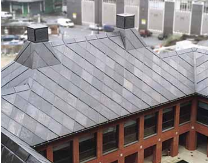
(الشكل 29.5) التسقيف ببلاط الرصاص - قاعة هابرداشاير (Haberdashers) في لندن. المهندس المعماريون: هوبكنز (Hopkins). الصورة: بإذن من جمعية مقاولي الرصاص.
