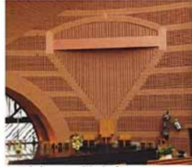
تفصيل داخلي - Interior detail
