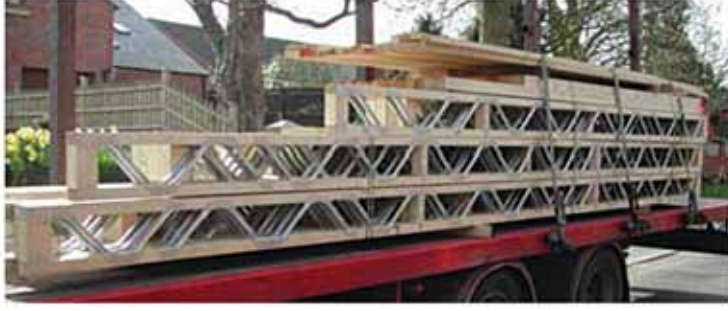
(الشكل 25.4) عوارض ثانوية ذات جسم معدني للأرضيات.
