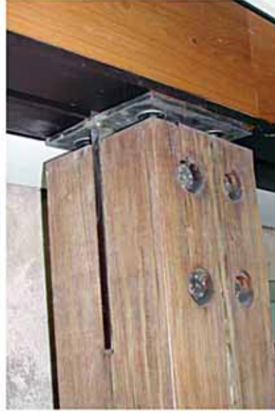
(الشكل 28.4) تفصيلة وصلة معدنية لعارضة من الخشب الصفائحي.
