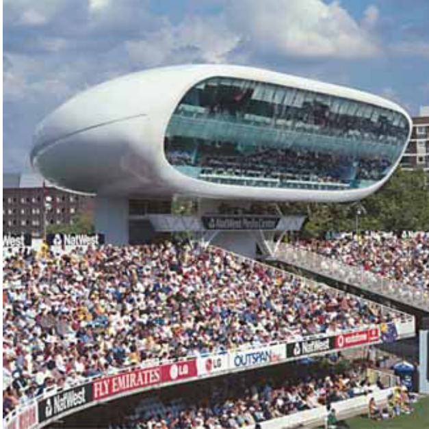
الشكل (21.5) أعمال التشييد نصف المونوكوكي من الألومنيوم - مركز اللورد الإعلامي، لندن. المماريون: أنظمة المستقبل (Future Systems). الصورة: بإذن من ريتشارد دايفس (Richard Davies).
