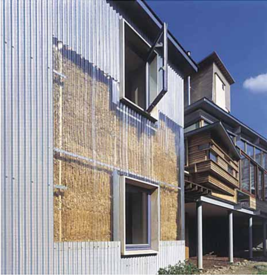
(الشكل 2.17) بالات القش في التشييد. المعماريون والصورة: (Sarah Wigglesworth Architects).
