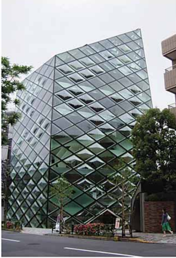
(الشكل 14.7) ألواح زجاج معينية محدبة - مخزن برادا، طوكيو.
