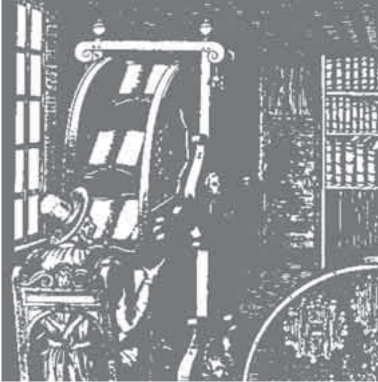
آلة القراءة على شكل دولاب تخيلها ووصفها الإيطالي أوغستينو رامبلي في كتابه المطبوع في باريس سنة 1588م Le diverse at artificiose machine. Pariz 1588
