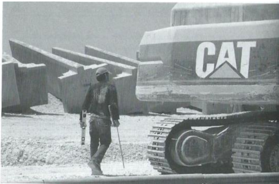
Une partie de la barrière cisjordanienne en construction. De nombreuses multinationales US et européennes sont impliquées dans la colonisation et les activités militaires d'Israël.
