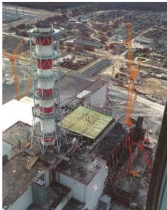
Le sarcophage recouvrant le Réacteur 4 en cours de construction, en octobre 1986.
