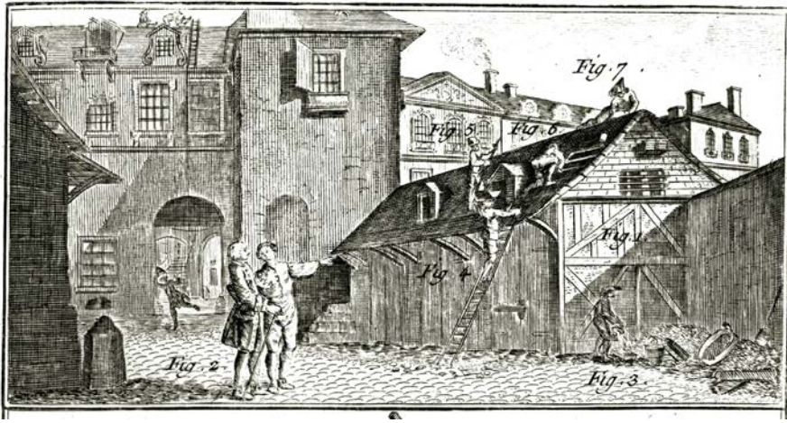
Cette gravure tirée de l' Encyclopédie fait partie de ces représentations des arts mécaniques, ici le travail des couvreurs. Diderot et D'Alembert, Encyclopédie ou Dictionnaire raisonné des sciences, des arts et des métiers , Genève, 1779.
