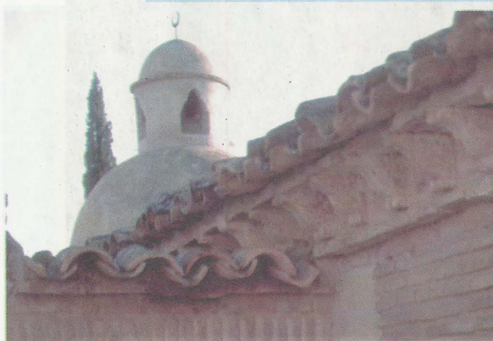
TOITURE EN TUILES DE LA GRANDE MOSQUEE
